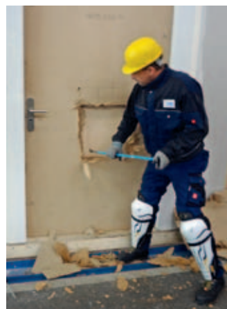
Versuch, innerhalb von 5 Minuten eine durchstiegsfähige Öffnung zu schaffen
